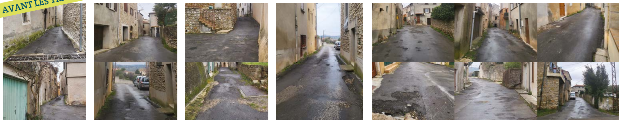
Rue de la Coste
